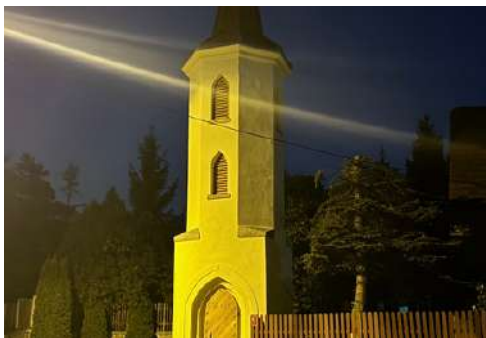
Modernizacja zabytkowej wieży w Zimniku
