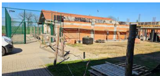
Rozbudowa Szkoły Podstawowej w Snowidzy poprzez budowę sali gimnastycznej
