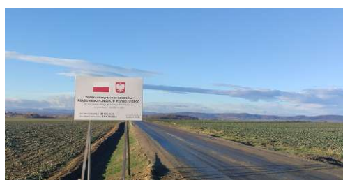
Przebudowa drogi gminnej w Niedaszowie w granicach działki nr 306 1.714.795,02 zł
