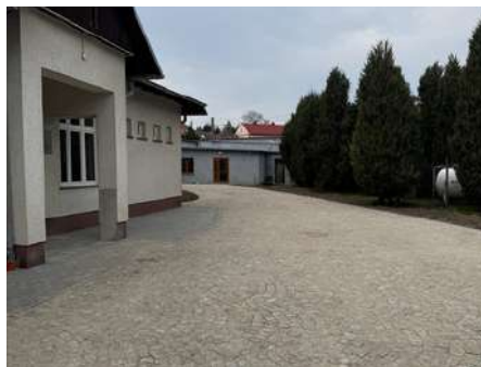
Utwardzenie nawierzchni przy świetlicy wiejskiej w Mściwojowie (w tym fundusz sołecki)
