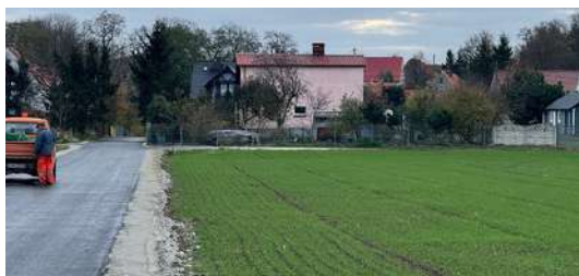
Przebudowa drogi gminnej w Snowidzy w granicach działek nr 438, 443, 448/1, 449 829.794,56 zł
