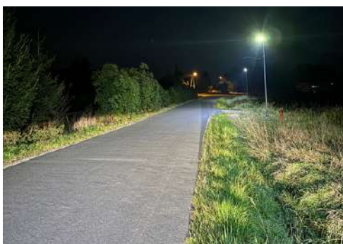
Budowa oświetlenia ulicznego we wsi Niedaszów dz. nr 117,132
