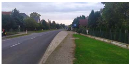
Budowa ciągu pieszo-rowerowego w miejscowości Niedaszów w ciągu drogi wojewódzkiej nr 374
