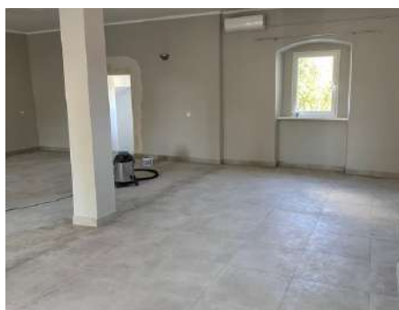
Remont świetlicy wiejskiej w Marcinowicach
