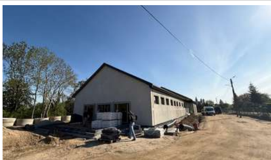
Budowa Centrum Rehabilitacyjnego w Snowidzy
