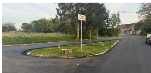
Przebudowa drogi gminnej w Siekierzycach w granicach działki nr 132 542.827,20 zł
